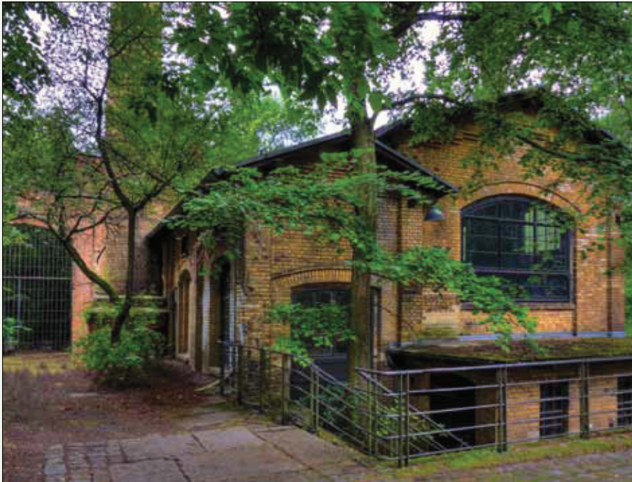
▲ Das recht gut erhaltene Heiz- beziehungsweise Kesselhaus vor dem Wagenreinigungsschuppen am südlichen Zaun. © Foto: M. Ahrendt
