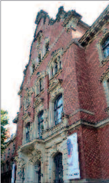
▲ Die ehemalige Reichsbahndirektion Berlin. © Foto: N. Kupfer
